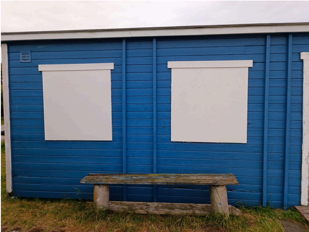
Materialboden uppfräschad och fönster borttagna
